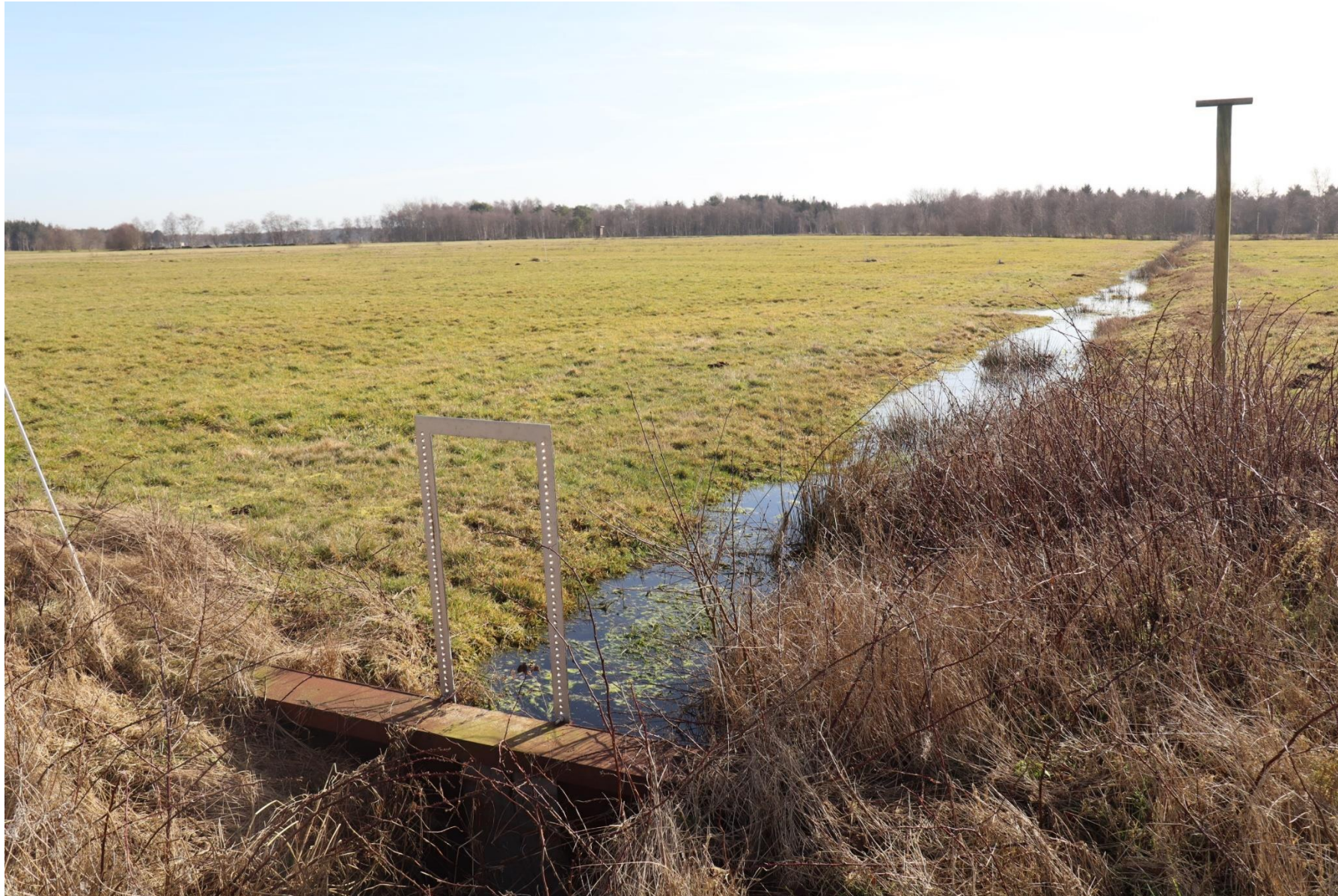
Grabenanstau im Gnarrenburger Moor (Oberklenkendorf) Bild: INBW, Ostfalia
